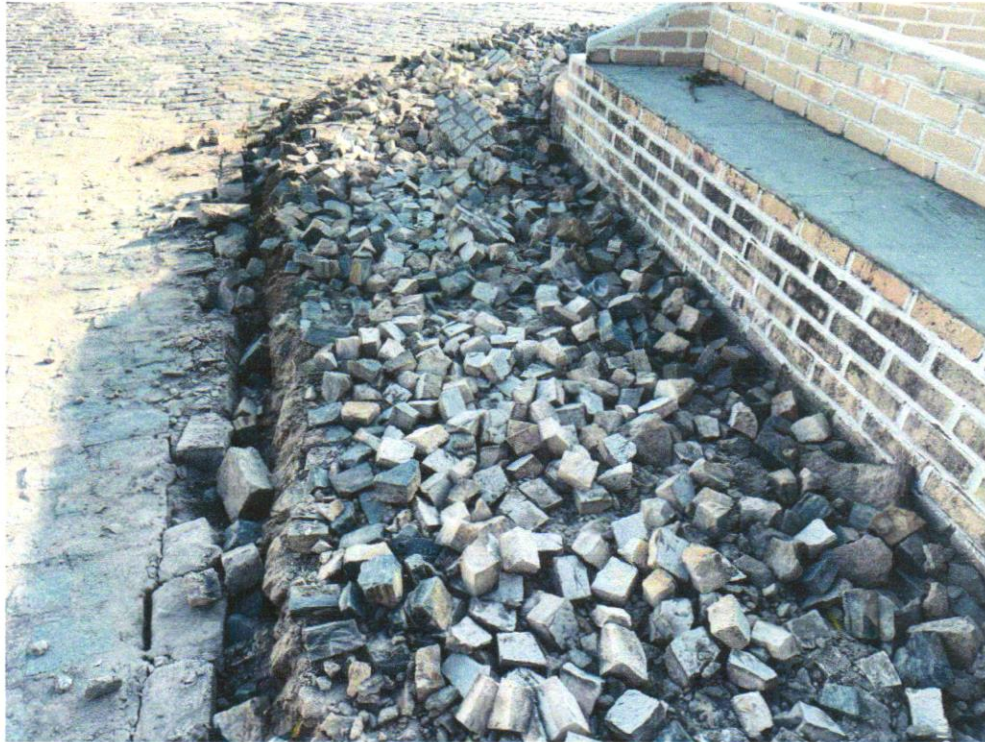
Foto 21 - Remoção de piso em Pedra Portuguesa
