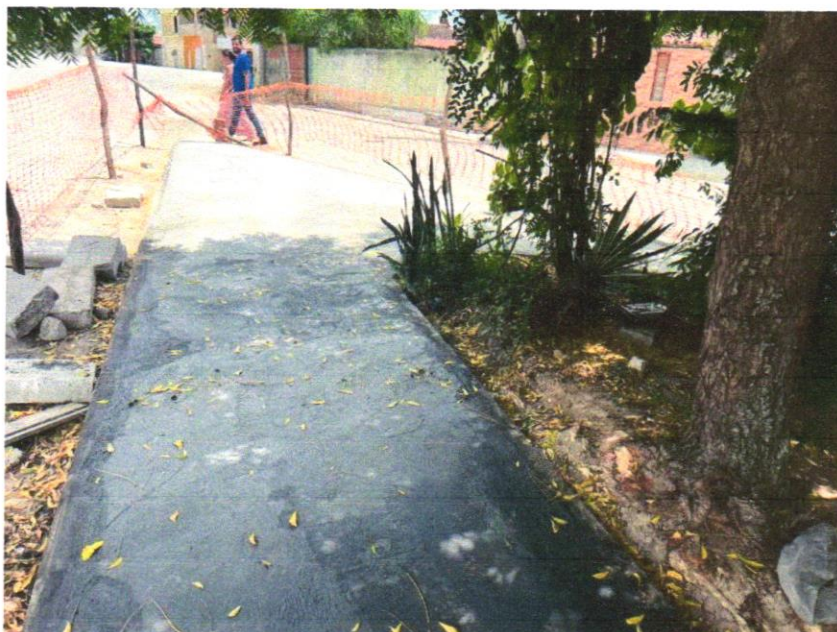
Foto 12 – PAVIMENTAÇÃO EM CONCRETO, COM ESPESSURA DE 7 CM, COM ACABAMENTO FEITO UTILIZANDO ALISADORA DE CONCRETO (HELICOPTERO), INCLUIDO TELA DE AÇO SOLDADA NERVURADA CA60, Q196 (3,11 KG/M 2 ), DIAMETRO DO FIO 5.0 MM, LARGURA = 2,45 M, ESPAÇAMENTO DA MALHA = 10 X 10 CM, JUNTA DE DILATAÇÃO EM PVC A CADA 2.00 M, CONCRETO FCK = 20 MPA
