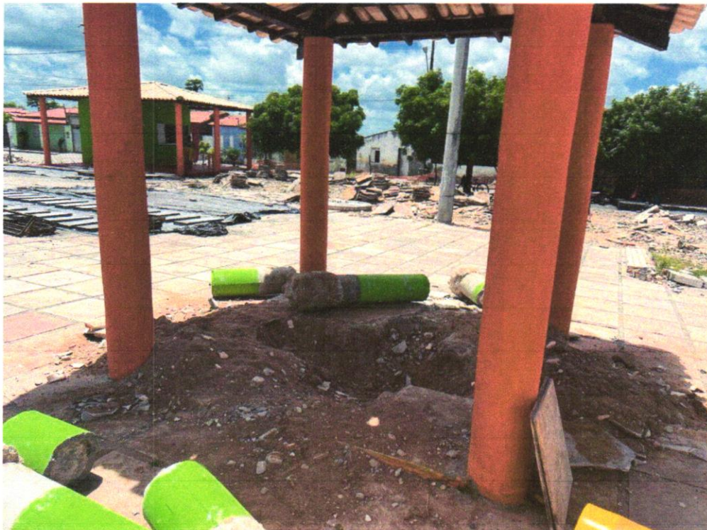
Foto 02 - Demolição de concreto manualmente
