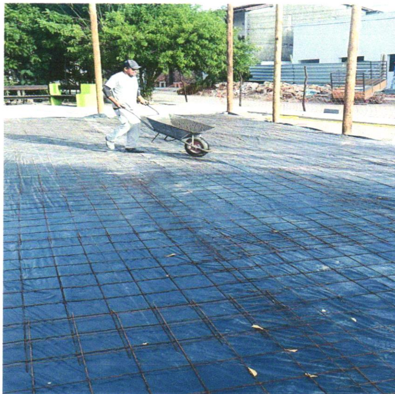
Foto 18 - FORNECIMENTO E INSTALAÇÃO DE TELA AÇO SOLDADA NERVURADA CA-60, MALHA 15X15CM, FERRO 4.2MM, PAINEL 2X3M, (1,50KG/M²), MALHA POP REFORÇADA GERDAU OU SIMILAR
