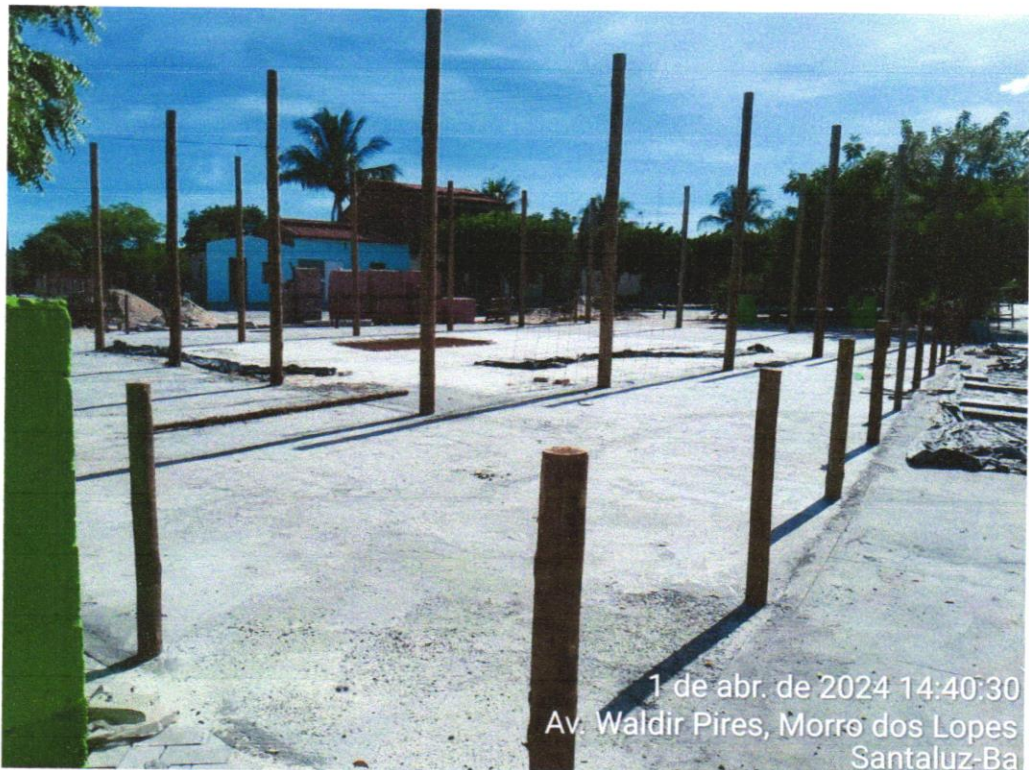
Foto 20 - PISO EM CONCRETO 20 MPA PREPARO MECÂNICO, ESPESSURA 7CM. AF_09/2020
