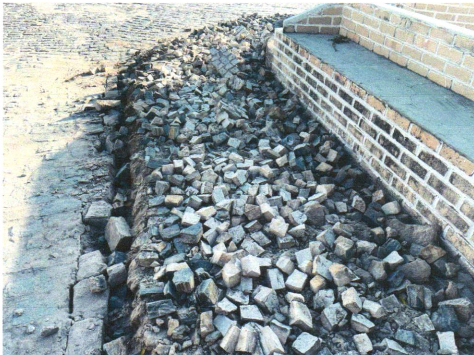
Foto 22 - Remoção de piso em Pedra Portuguesa
