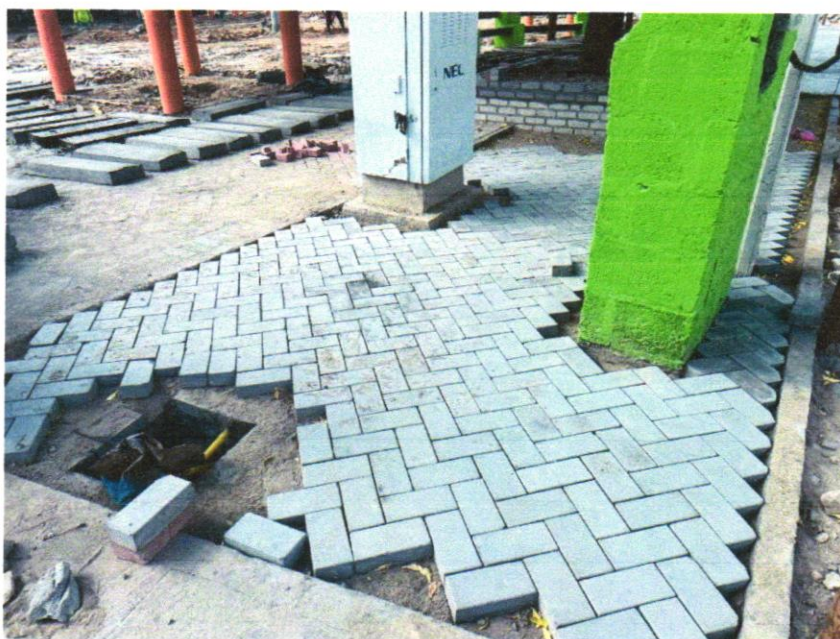
Foto 14 - Pavimentação em bloco de concreto vibroprensado, intertravado, cor natural, 10x20cm, e=6cm, 46un/m 2 , NBR9781, Fck(min)=35MPa, sob coxim areia grossa compactada c/ placa vibratória, e(comp.)=6cm, rejuntado c/ areia fina.
