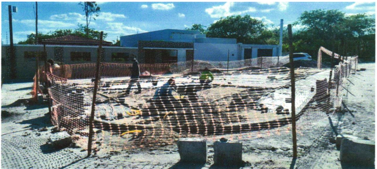
Foto 01 - Tapume de proteção em tela de polietileno h=1,20 com bloco de concreto
