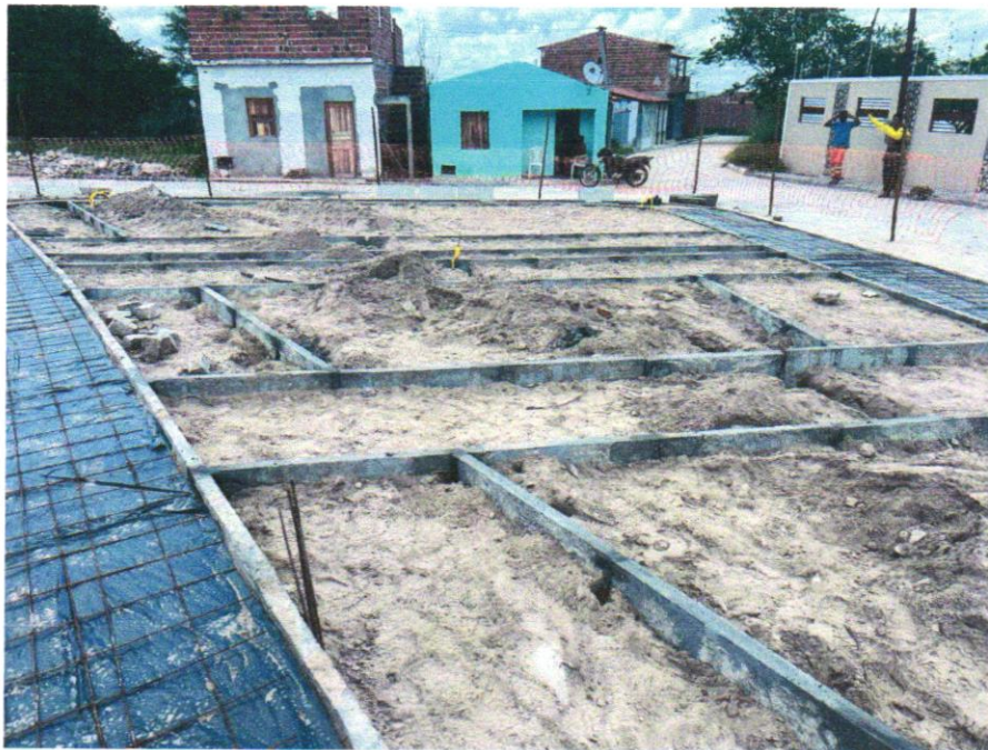
Foto 07 - ASSENTAMENTO DE GUIA (MEIO-FIO) EM TRECHO RETO, CONFECCIONADA EM CONCRETO PRÉ-FABRICADO, DIMENSÕES 80X08X08X25 CM (COMPRIMENTO X BASE INFERIOR X BASE SUPERIOR X ALTURA), PARA URBANIZAÇÃO INTERNA DE EMPREENDIMENTOS. AF_06/2016
