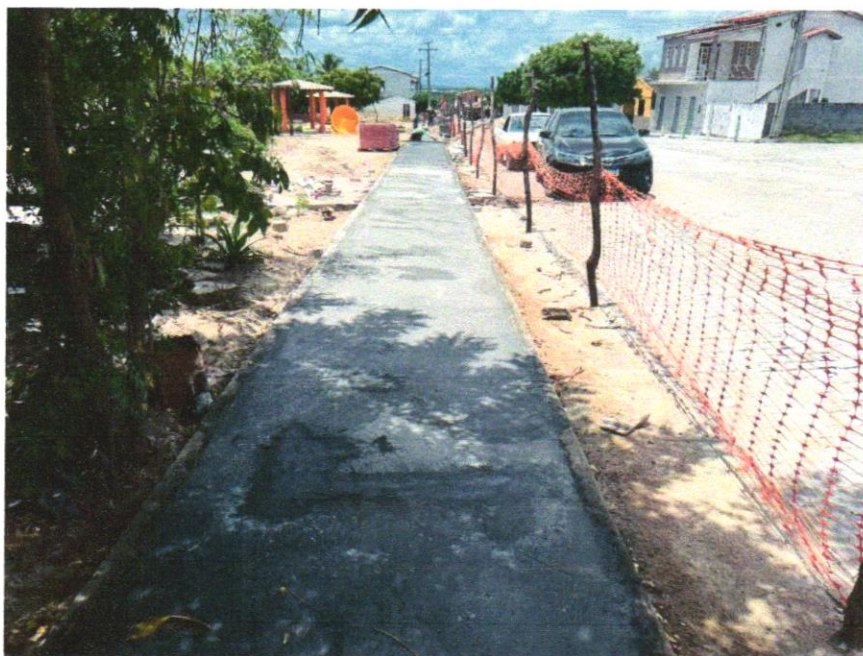
Foto 11 – PAVIMENTAÇÃO EM CONCRETO, COM ESPESSURA DE 7 CM, COM ACABAMENTO FEITO UTILIZANDO ALISADORA DE CONCRETO (HELICOPTERO), INCLUIDO TELA DE AÇO SOLDADA NERVURADA CA60, Q196 (3,11 KG/M 2 ), DIAMETRO DO FIO 5.0 MM, LARGURA = 2,45 M, ESPAÇAMENTO DA MALHA = 10 X 10 CM, JUNTA DE DILATAÇÃO EM PVC A CADA 2,00 M, CONCRETO FCK = 20 MPA
