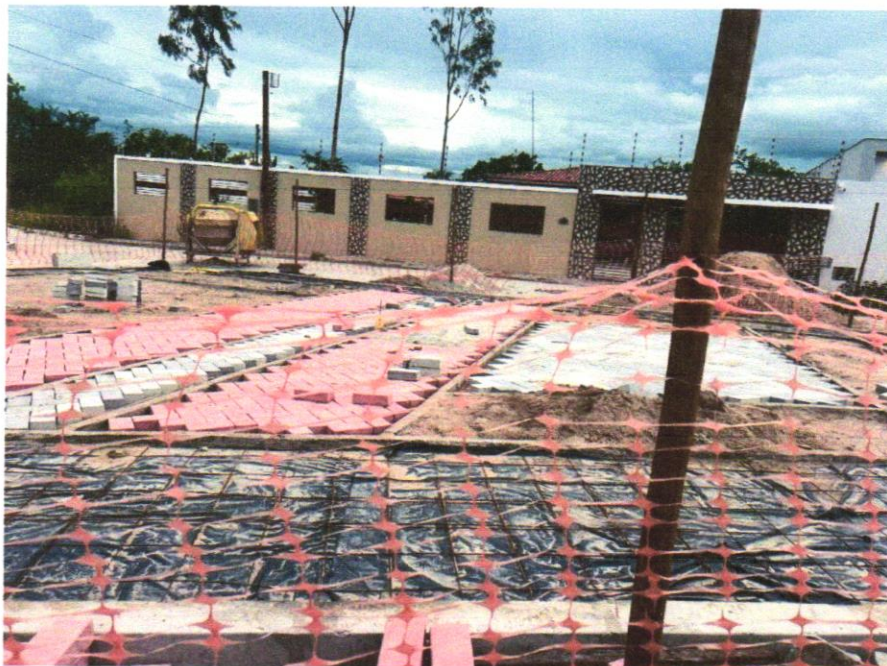
Foto 16 - Pavimentação em bloco de concreto vibroprensado, intertravado, colorido, 10x20cm, e=6cm, 46un/m 2 , NBR9781, Fck(min)=35MPa, sob coxim areia grossa compactada c/ placa vibratória, e(comp.)=6cm, rejuntado c/ areia fina.
