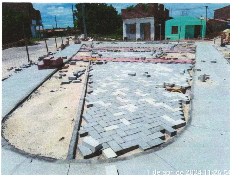
Foto 13 - Pavimentação em bloco de concreto vibroprensado, intertravado, cor natural, 10x20cm, e=6cm, 46un/m 2 , NBR9781, Fck(min)=35MPa, sob coxim areia grossa compactada c/ placa vibratória, e(comp.)=6cm, rejuntado c/ areia fina.
