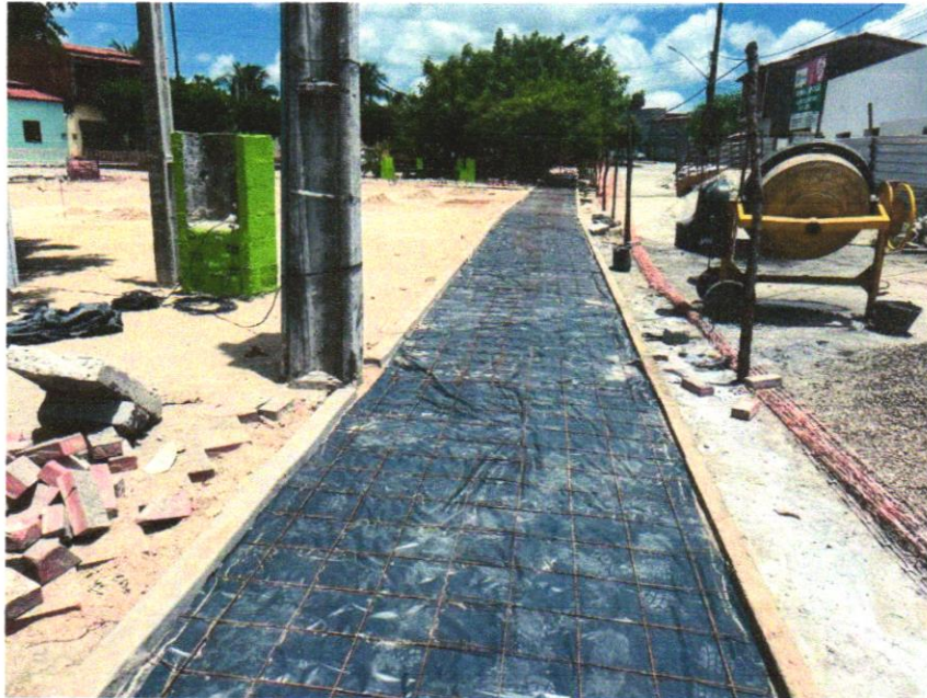
Foto 17 - APLICAÇÃO DE LONA PLÁSTICA PARA EXECUÇÃO DE PAVIMENTOS DE CONCRETO. AF_11/2017
